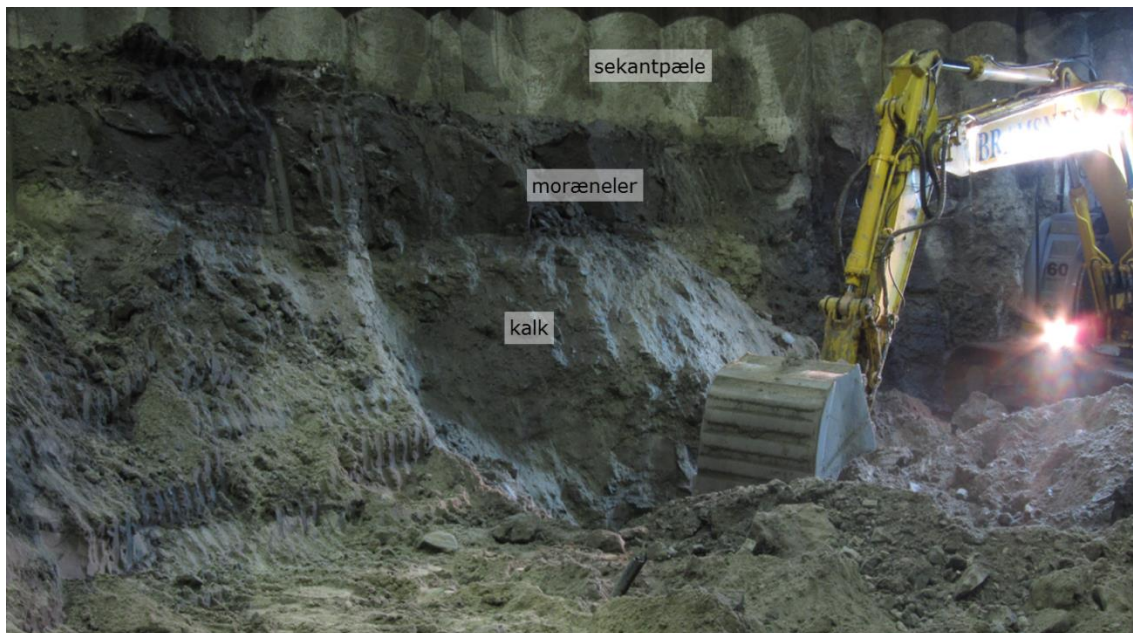
Figur 4.31. Grænsen mellem moræneler og kalk i Cityring-skakten for Frederiksberg station. Bemærk den skarpe grænse mellem kalk og moræne, og graveskovlens tandmærker i både moræne og kalk. Foto: Jens Galsgaard.
