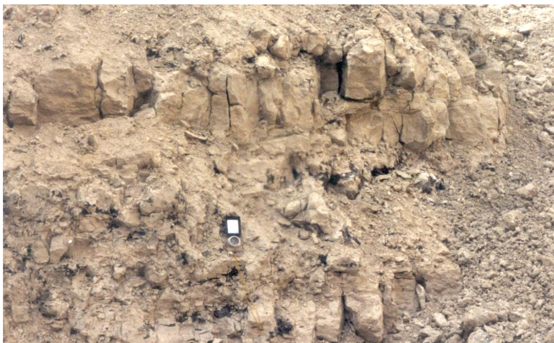
Figur 4.16. Tætsiddende vertikale sprækker i bryozokalk i udgravning i Sydhavnsgade, København, tæt på Carlsbergforkastningen. Sprækkerne er parallelle med forkastningen.
